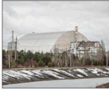
Eine Schutzhülle bedeckt den havarierten Reaktorblock 4 des Atomkraftwerks Tschernobyl. – F.: imago
